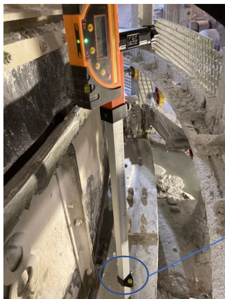
Figure 29 Vérification du niveau sur la cellule
