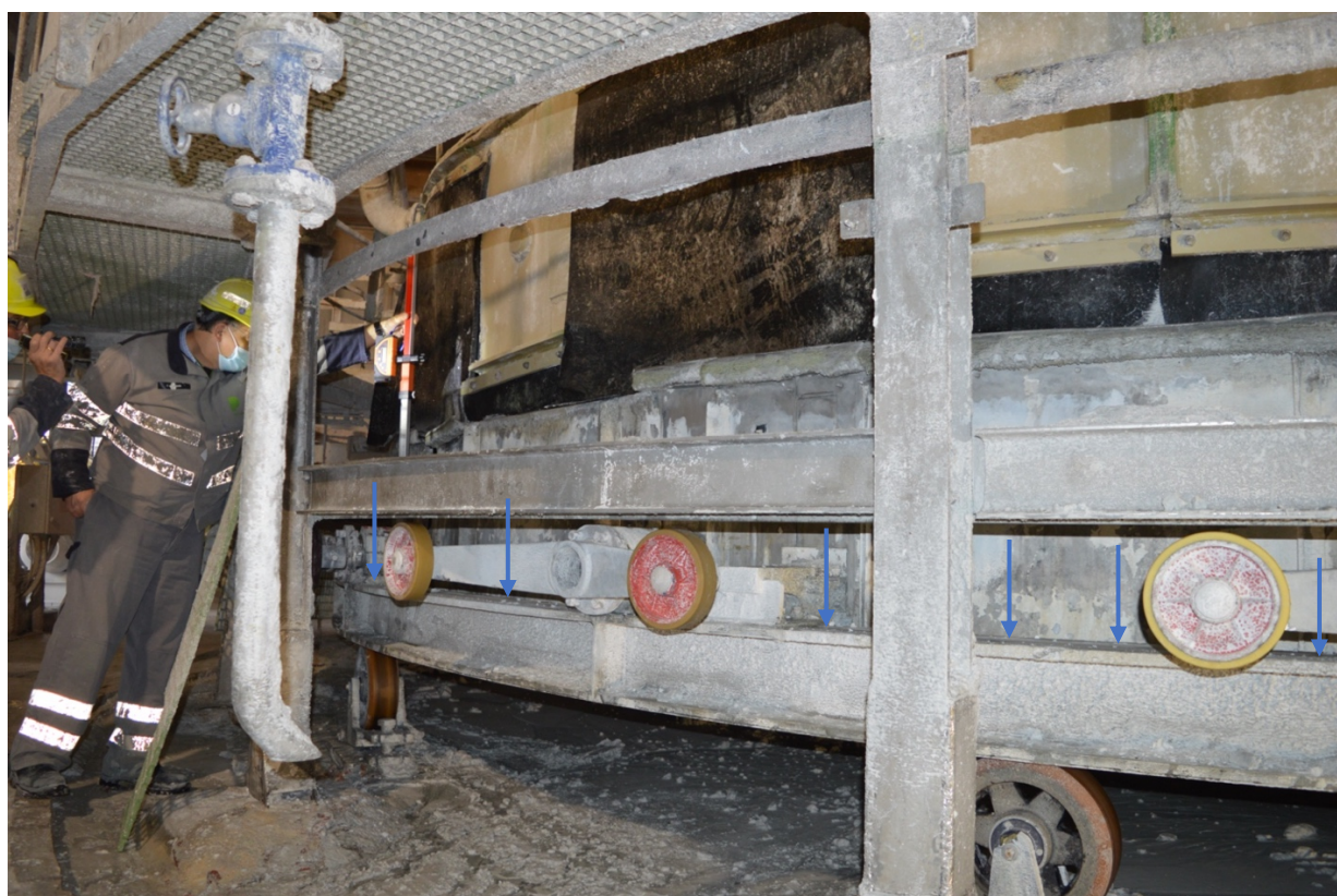
Figure 28 Vérification du niveau sur le filtre
